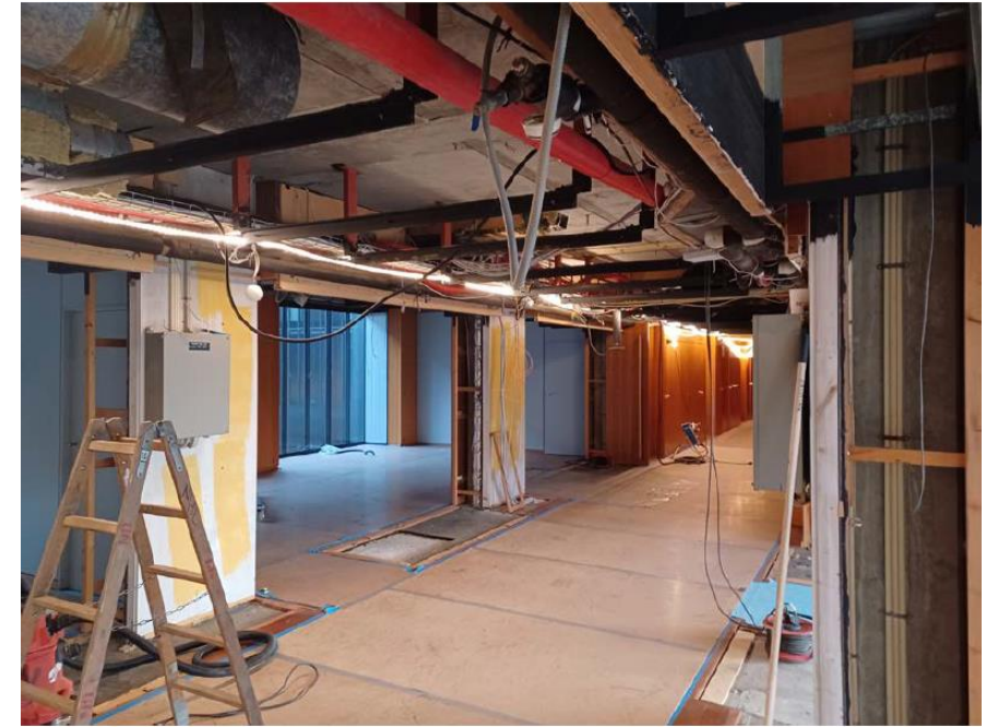
Nedtagning af ventilation
